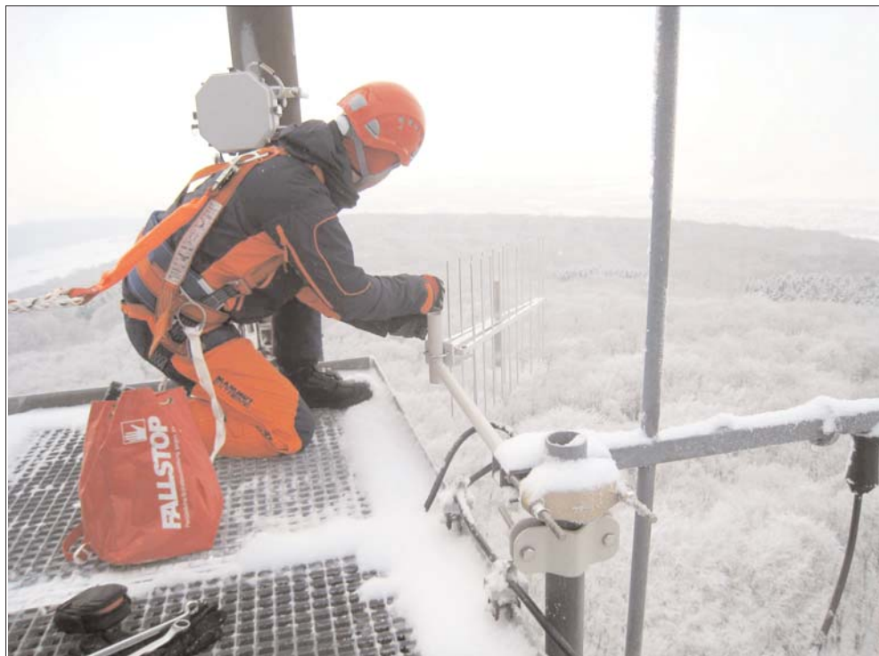
Die Montage des Repeaters fand bei arktischen Temperaturen und somit unter erschwerten Bedingungen statt.
